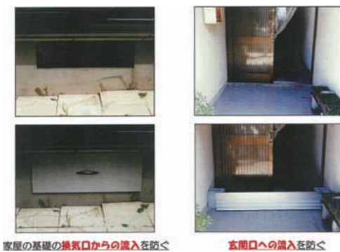
写真-2 床下浸入水防止板
