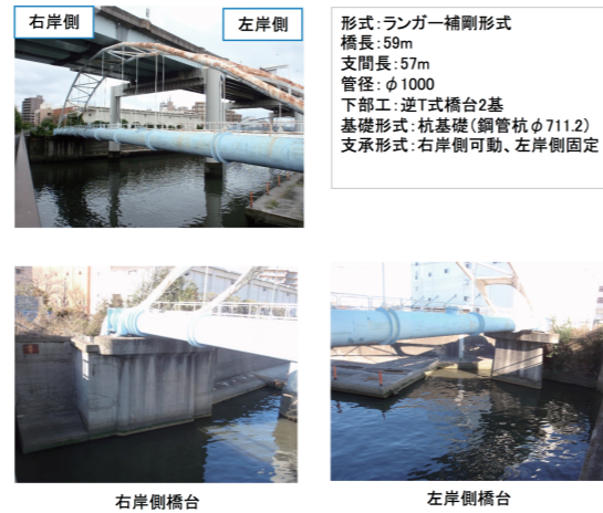
写真-2 水管橋現況
