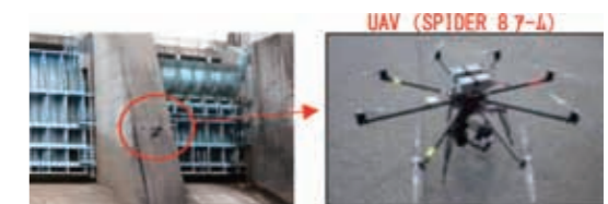
写真-2 UAV撮影状況
