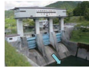
写真-1 大野頭首工(右岸下流から望む)
