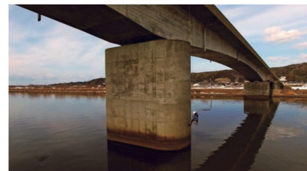
写真-4 特殊高所技術による点検状況
