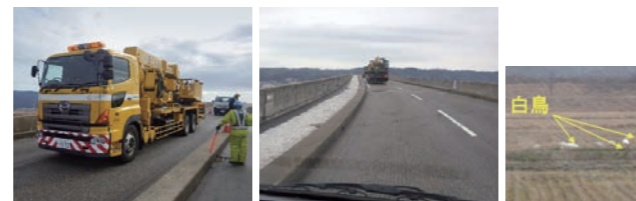
写真-1 大型点検車両 写真-2 車両通行状況
