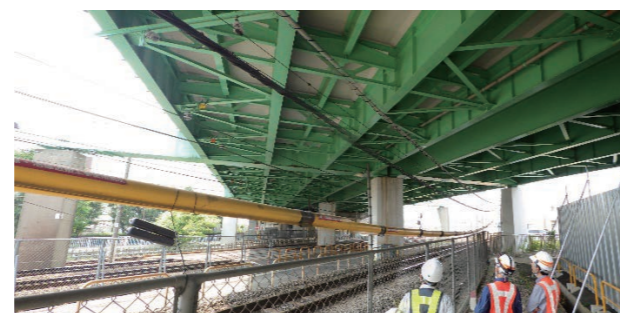
図-2 B橋高架下状況
