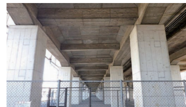
図-5 橋脚柱RC巻立て状況
