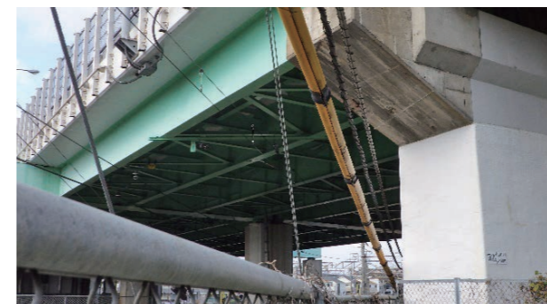
図-15 特別高压架線状況
