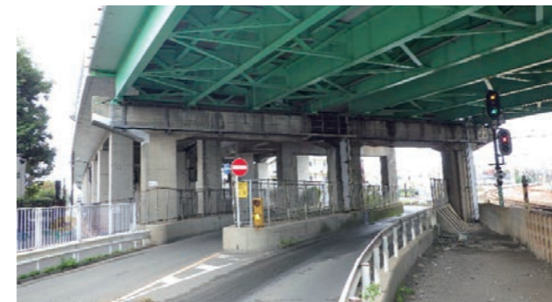
図-16 終点側橋脚周辺状況
