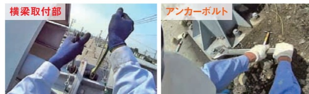
図-5 点検状況写真
