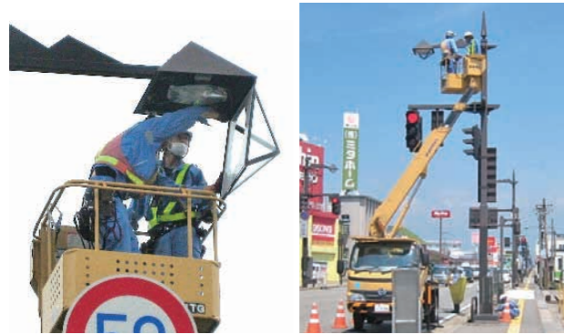
図-3 通常の点検状況
