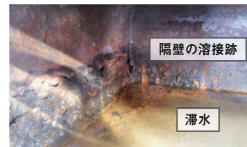
写真-2 鋼製地覆内部
