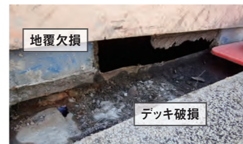
写真-3 デッキプレート上面
