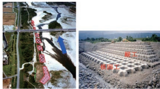
図-1 縦工の整備 1)
