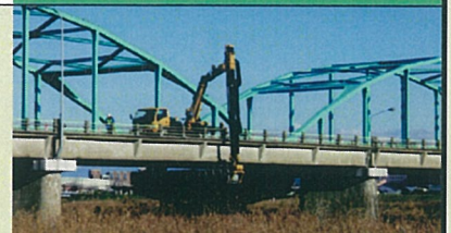
橋梁点検状況（実績400橋）
