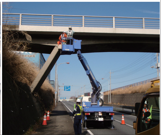
橋梁点検(花ヶ谷戸橋)
