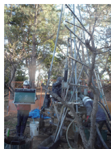
ボーリングマシン 掘進作業状況
